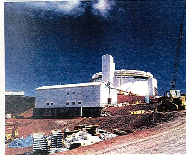
写真1 マウナケア山頂工事現場
