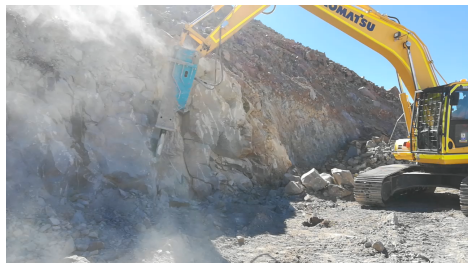
道路拡張工事
