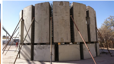
完成、仮組試験も合格した基礎。
