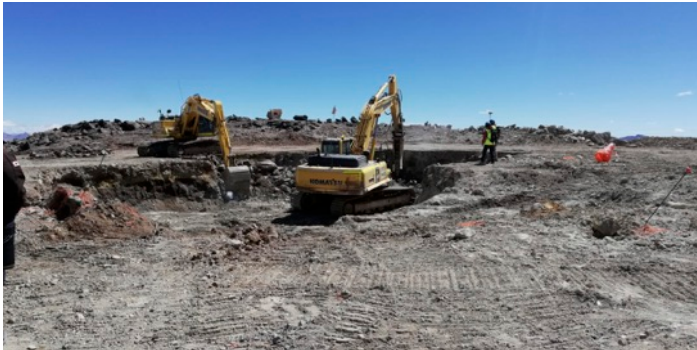
山頂での工事の様子。
