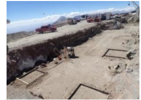
運用棟基礎工事
