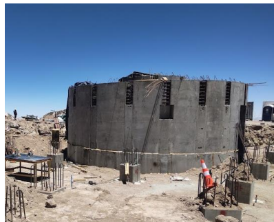
プレキャスト法で望遠鏡基礎
