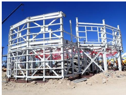
エンクロージャ鉄骨工事
