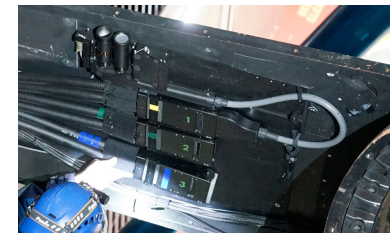
望遠鏡スパイダー赤外・フロント側に取り付けられた PFS ファイバーコネクタ。3 本のケーブルに対応して 3 組ある。
