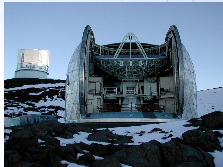
Caltech Submillimeter Observatory (CSO) : カリフォルニア工科大学が1987年から運用してきた口径10.4m電波望遠鏡。2015年に運用終了。
