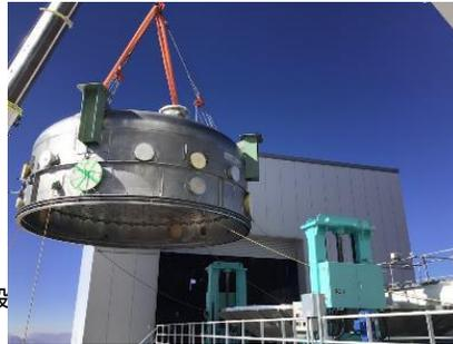
蒸着装置の輸送、組み立ての様子と、据え付けが終わった蒸着窯
