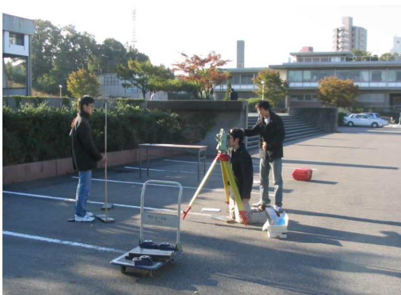
駐車場での測量＝水平だし作業
