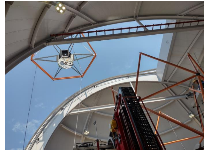
2021年6月21日 京大せいめい副鏡再蒸着に向けた トップリング取り外し作業
